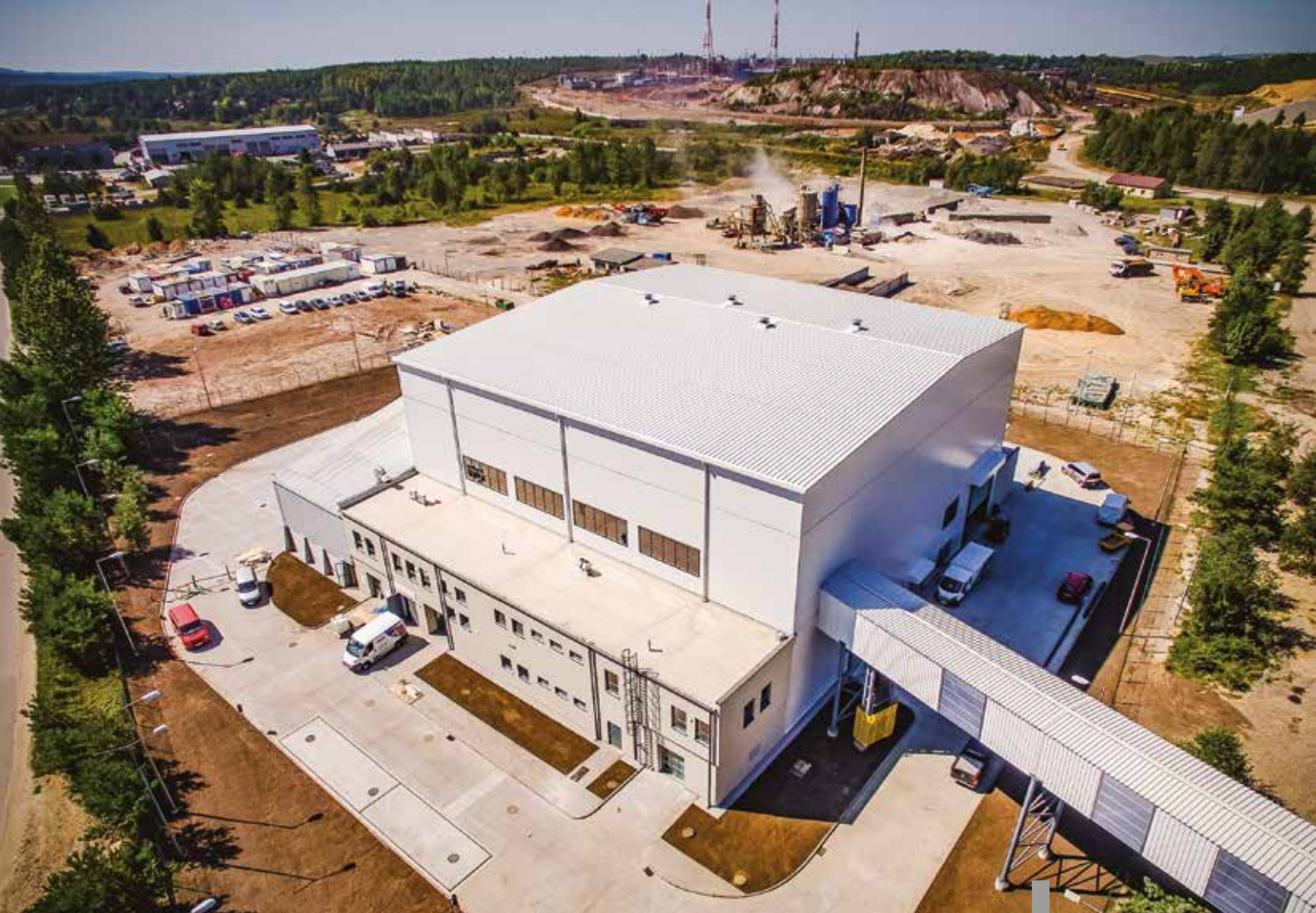
Zakład Przerobu Odpadów Poflotacyjnych Flotation Tailings Processing Plant
